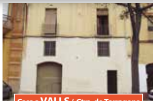
Casa a VALLS / Ctra. de Tarragona
