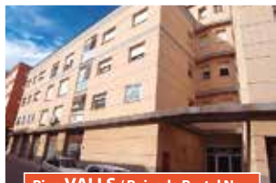
Pis a VALLS / Baixada Portal Nou
